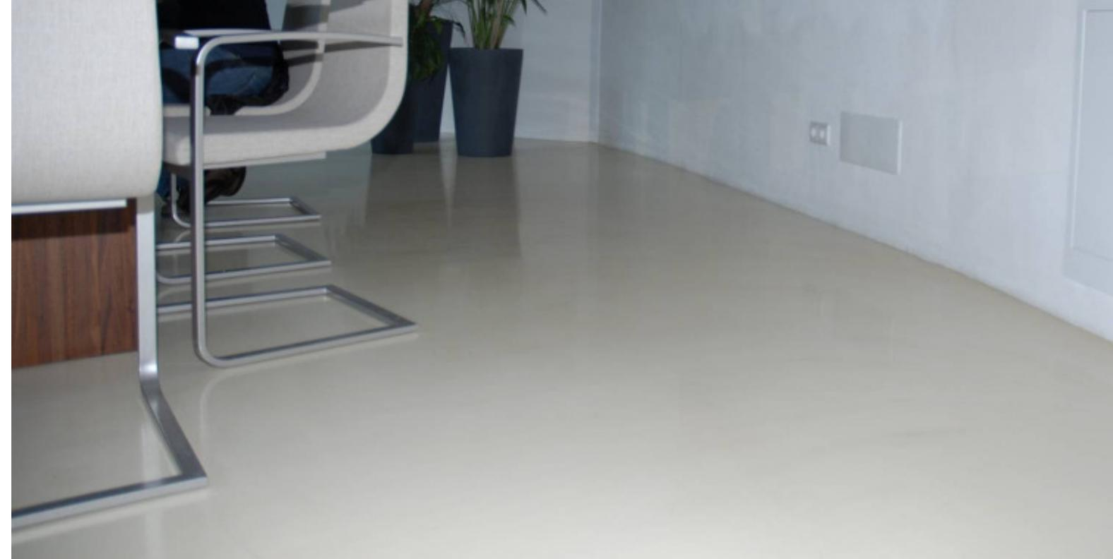
Die Verlaufsbeschichtung mit Wischtechnik erlaubt durch eine gewollte Schlierenbildung ein unhomogenes und dadurch lebhaft wirkendes Bodenbild. Dadurch verschwindet der oft steril wirkende homogene Eindruck eines traditionellen Bodenbelages.
